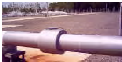
Monolithic insulating joints with surge diverter Giunto isolante monolitico con scaricatore di protezione
